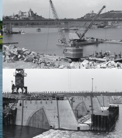
Oben: Befestigungsarbeiten an der Gewässer- sohle (1962-1965) Unten: letzte Fertigungsarbeiten (1962-1965)
