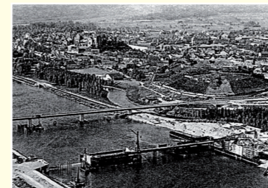
Luftbild aus der Bauzeit 1962-1965 Richtung Breisach
