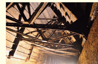
Traggerüst des Sektors vor Instandsetzung
