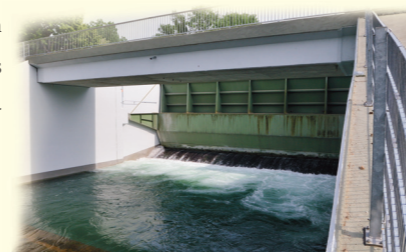
Möhlinwehr mit Wehrbrücke
