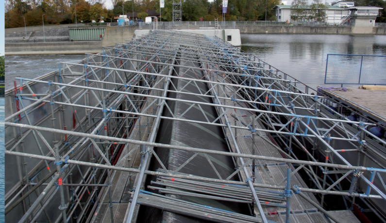
Instandsetzungsarbeiten an einem Sektor
